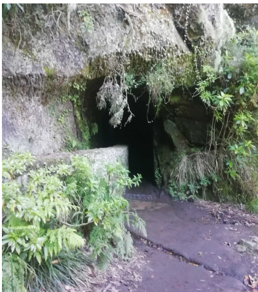
Entrada de túnel, Levada do Caldeirão Verde
